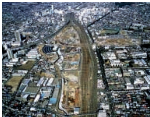
昭和56年事業着手前の様子
