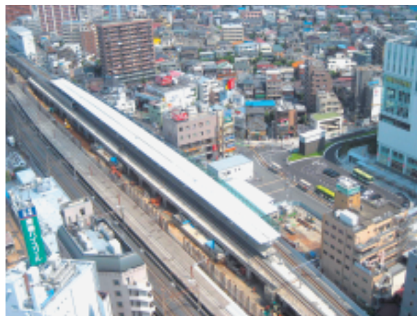
鉄道高架施工状況
